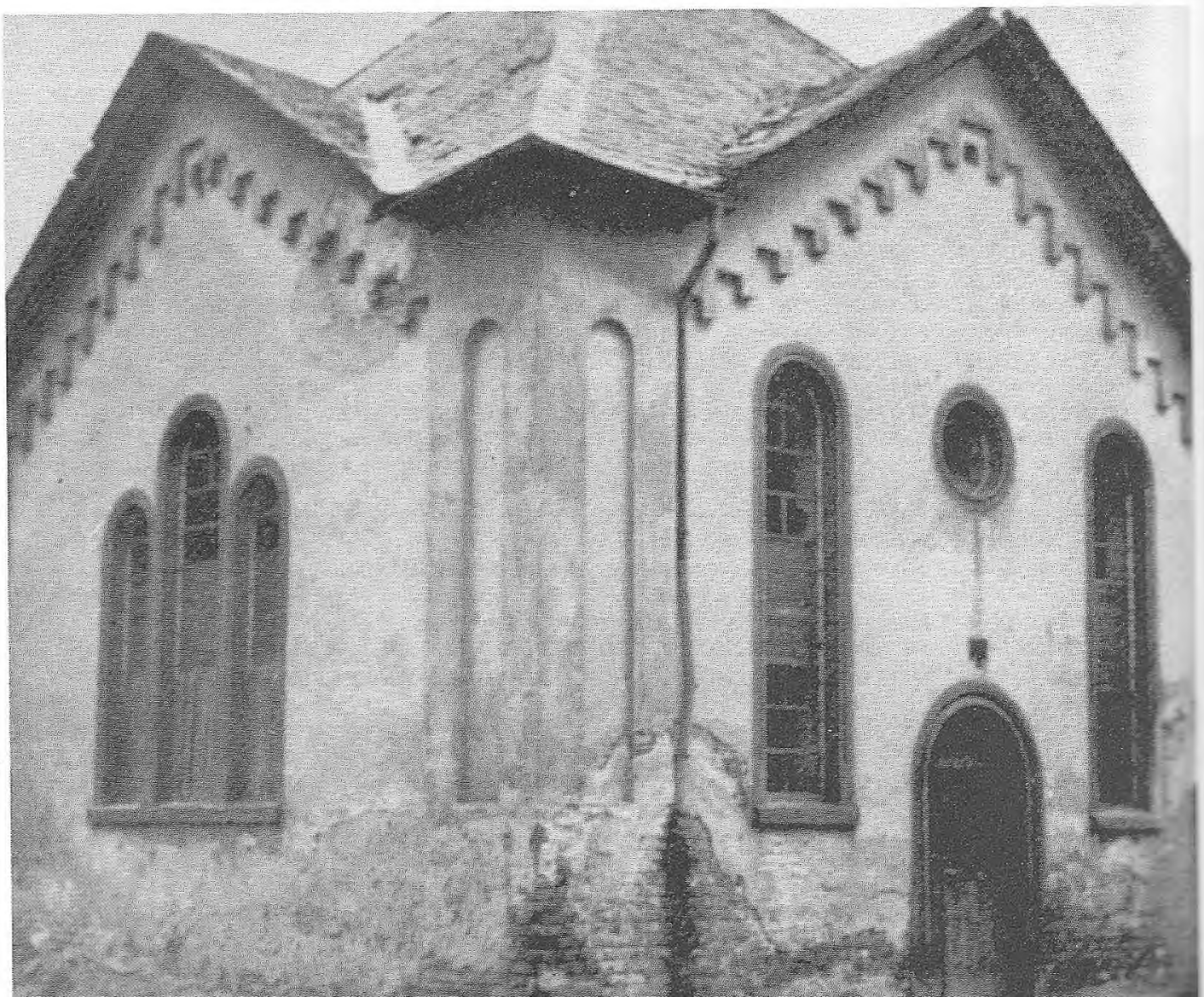
Ehemalige Synagoge in der Bisseser Straße, erbaut 1864–1865
